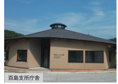
庁舎整備事業 (本庁・因島総合支所・百島支所・御調支所) 2億6,707万円
